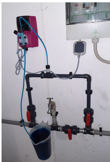
Für die Pumpe werden jedes mal 3 l Wasser-Impfstoff-Gemisch mit blauem Wasserstabilisator vorbereitet, welches dann über den Zeitraum in die Wasserleitung zugegeben wird.
